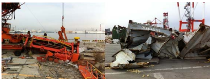
震災後仙台港の様子
